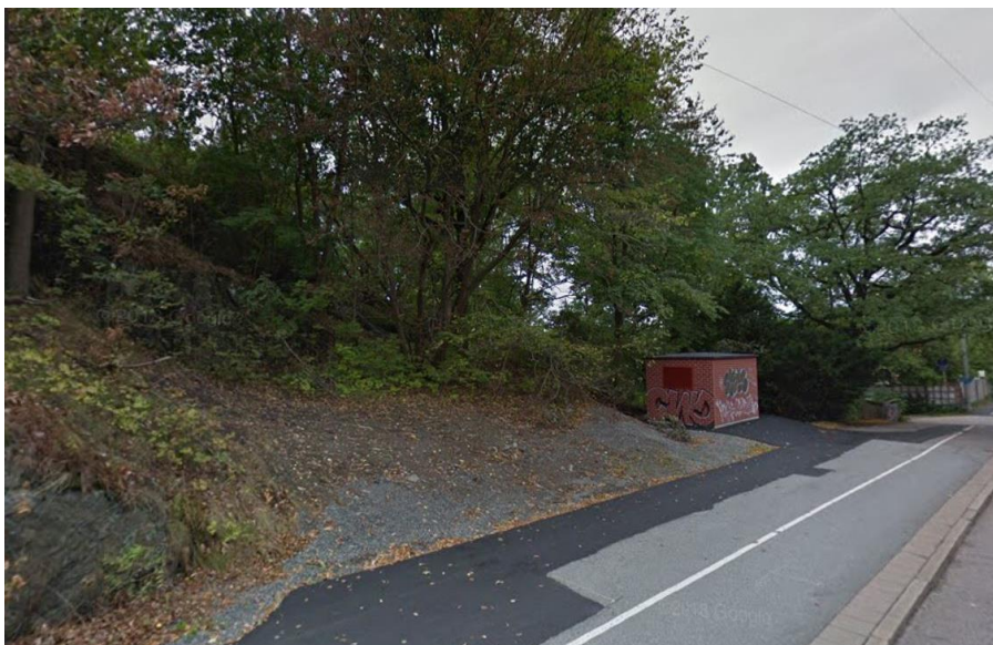
Figur 36 Befintlig transformatorstation där ett nytt apparatrum kommer att byggas i projektet. Omkringliggande miljö ska läkas så att det liknar intilliggande skogsbacke.
