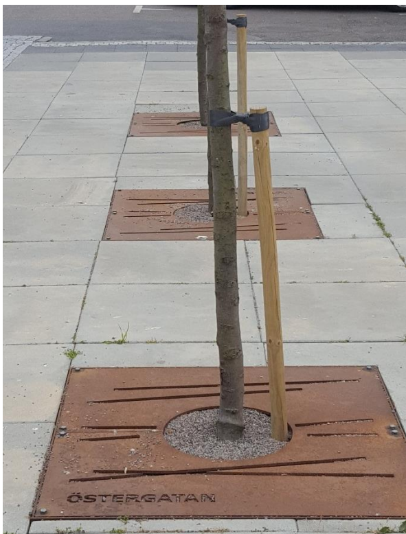
Figur 42 För att göra ytan ända in till trädstam användbar som vistelseyta förordas träd i markgaller på busshållplatserna.
